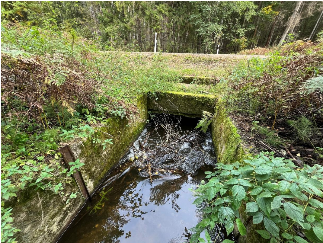
Joonis 3. Omal ajal rajatud regulaator koosneb betoon kastist, plaadist ja binokkeltruubist. Regulaatori läbilaskevõime suuremate vooluhulkade korral on piiratud.
