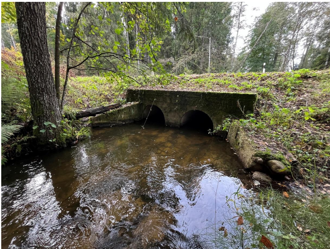
Joonis 4. Binokkeltruubi väljavool Ahelo jõel.
